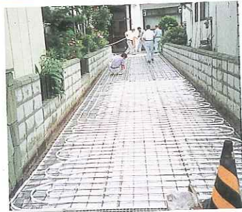
配管敷設工事風景
