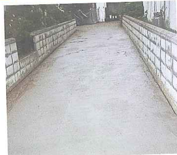
コンクリート打設・アスファルト仕上げ工事
